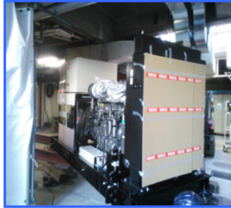
設置場所へ据付される様子
