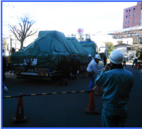
当院へ設備機器が搬入されているところ
